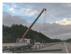
写真-3 ガードレール撤去状況(1月2日)
